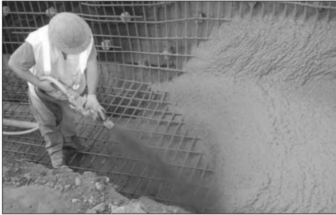
Рис. 2. Торкретирование мокрым способом
