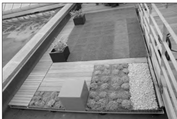
Рис. 1. Дизайн комбинированных покрытий эксплуатируемой кровли
